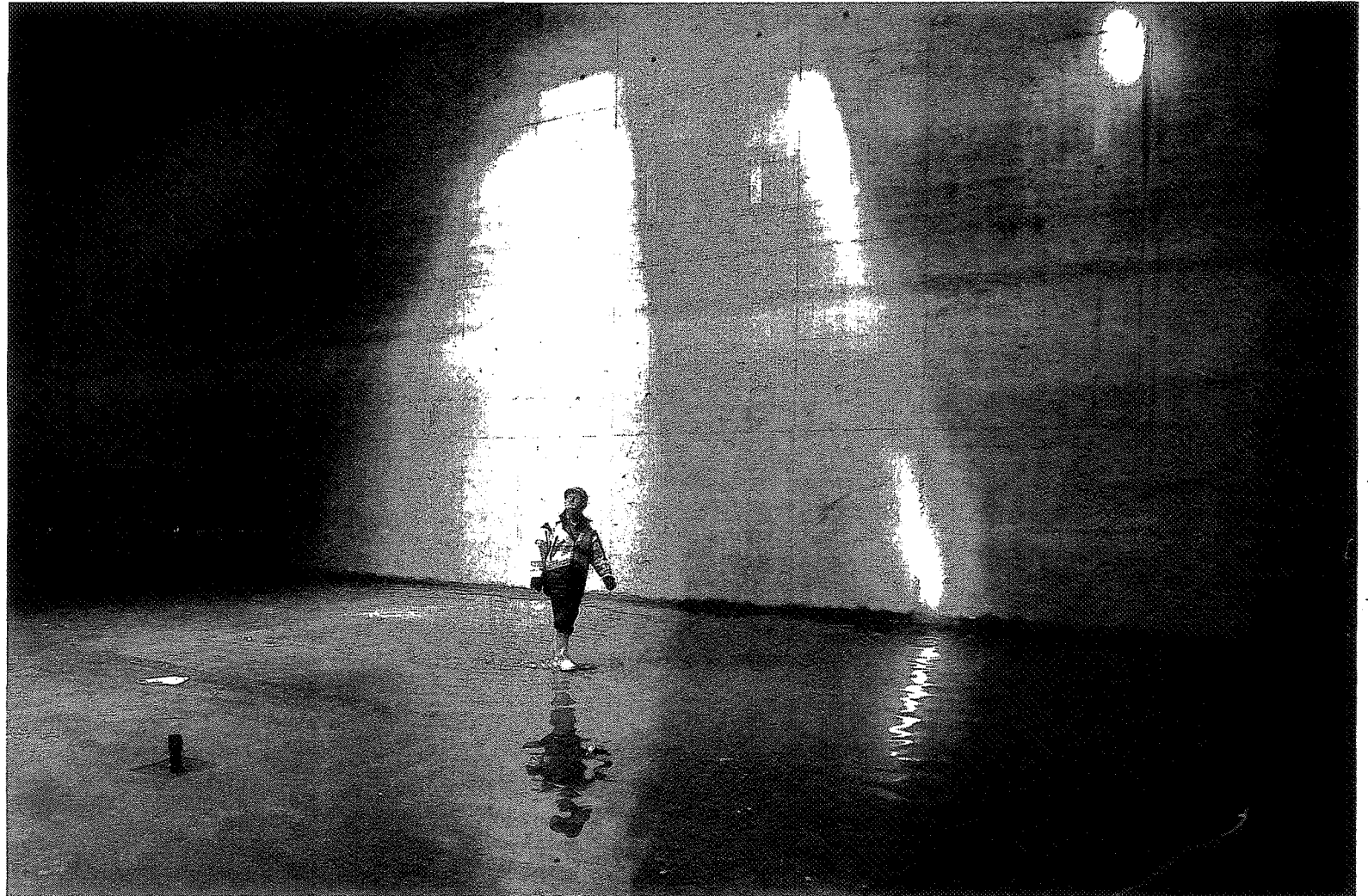
De 'startschacht' op het Stationseiland: hier wordt straks begonnen met het boren van de Noord/Zuidlijn. De bodem ligt twintig meter onder NAP. FOTO OLAF KRAAK/ANP
